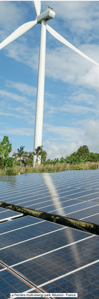
La Perrière multi-energy park, Réunion - France.
