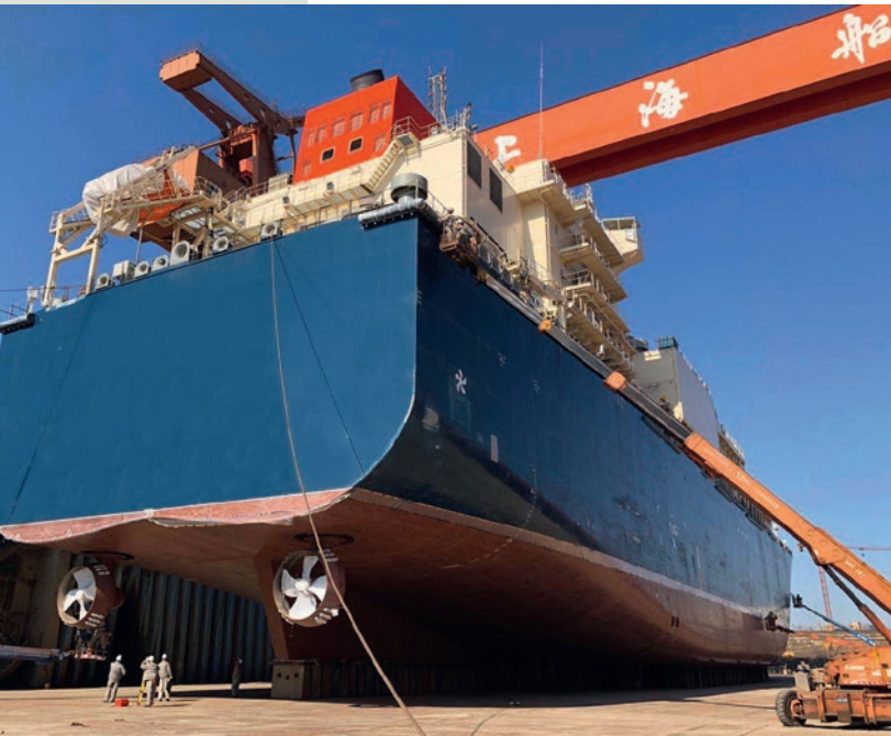
Chantier de construction d'un avitailleur en GNL, à Shanghai.
