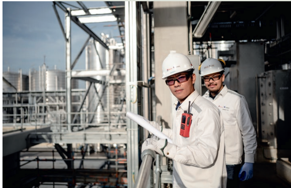
Usine de bioplastiques à Rayong, en Thaïlande.
