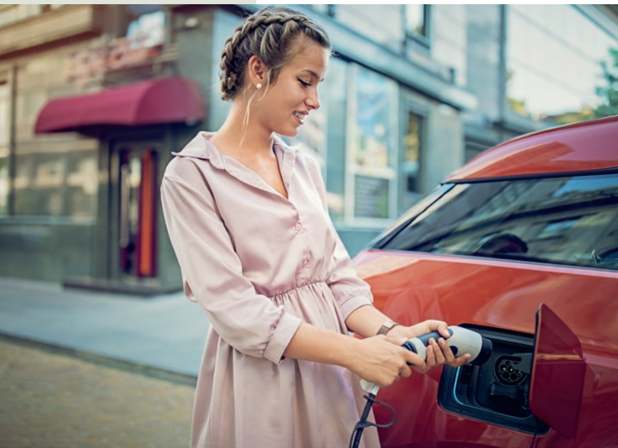
Recharge d'un véhicule électrique sur la voie publique.
